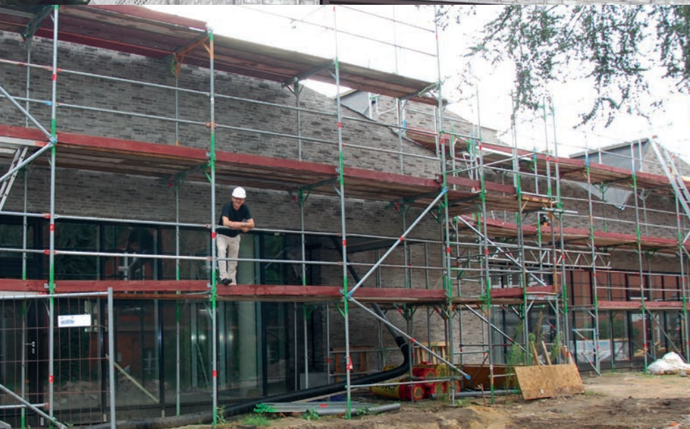
Hochschularchitekt Andreas Poppinga auf der großen Baustelle am Fachbereich Seefahrt und Maritime Wissenschaften.
